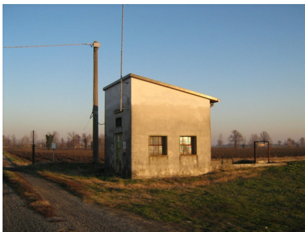
Figura 149 – Impianto irriguo Bissolina.
