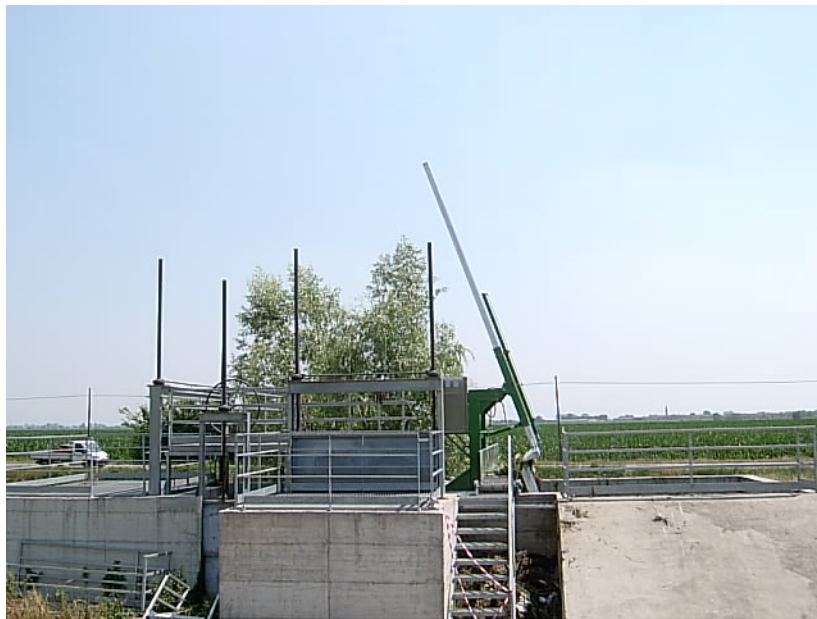
Figura 55 - Pozzetto imbocco diramatore Torre e Isola al termine del Nuovo Bolla.
