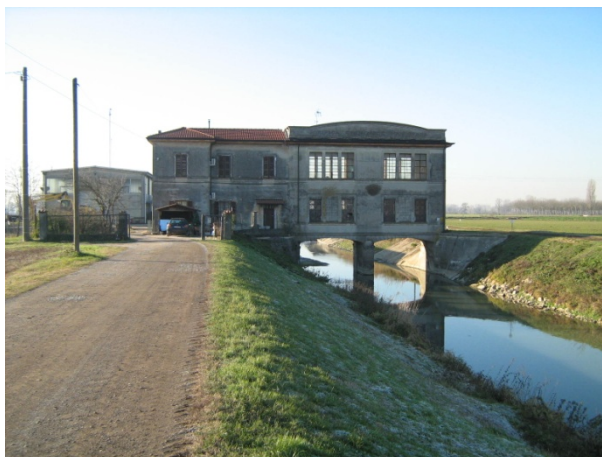
Figura 140 – Chiavica Canale Acque Alte.
