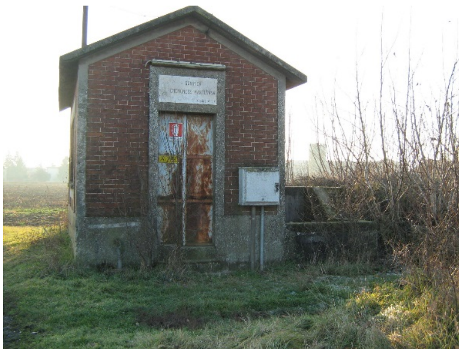
Figura 51 - Impianto San Daniele.
