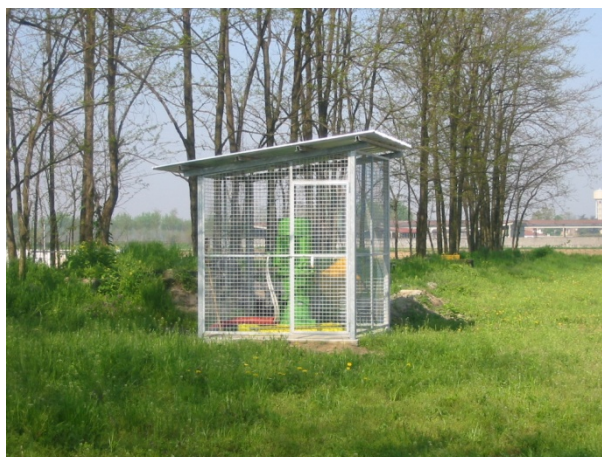
Figura 151 – Impianto irriguo Pozzo Paderno.
