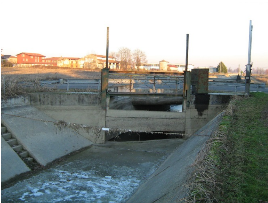
Figura 44 - Sostegno sul canale principale di Foce Morbasco per derivazione Diramatore Stagno.
