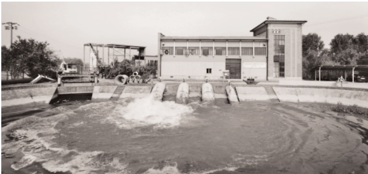
Figura 158 - Impianto di sollevamento di Foce Morbasco.
