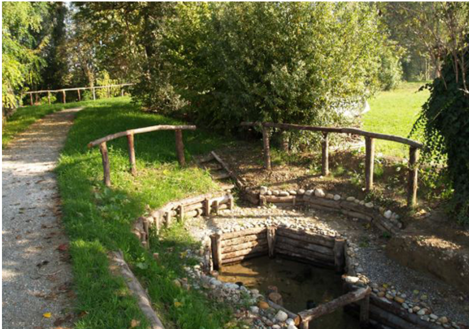
Figura 161 – Testa di fontanile ristrutturata.
