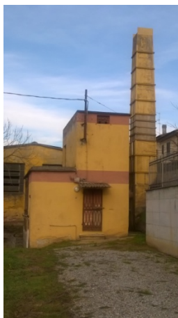
Figura 152 – Impianto irriguo Cavatigozzi.
