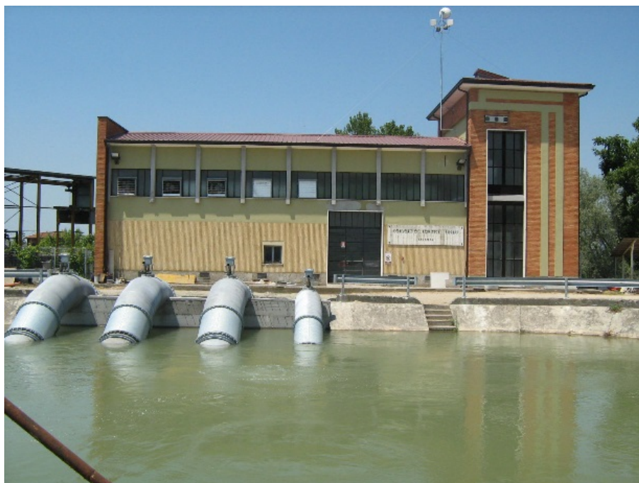
Figura 38 - Impianto di Foce Morbasco.
