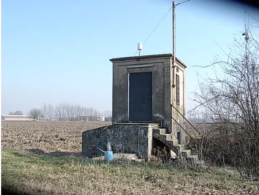
Figura 61 – Impianto di sollevamento Ribero.
