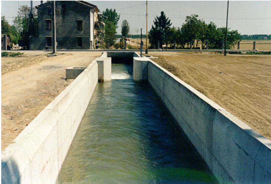
Figura 53 - Manufatto di presa Canale Nuovo Bolla dalla Ciria.
