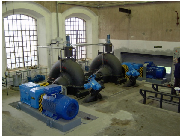
Figura 138 - Impianto di sollevamento S. Paolo R/Oglio.
