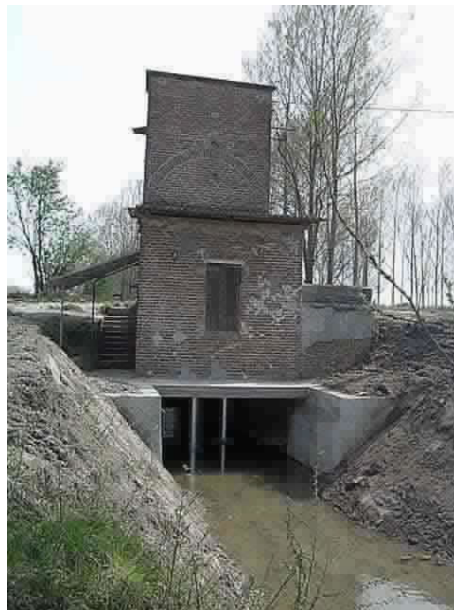
Figura 139 – Impianto idrovoro Monticelli R/Oglio.
