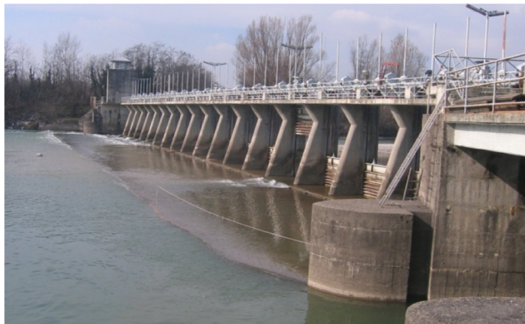
Figura 147 – Traversa di derivazione Retorto.
