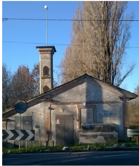
Figura 142 – Impianto idrovoro 'Binanuova'.
