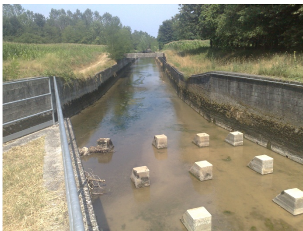
Figura 145 – Scolmatore di Genivolta.
