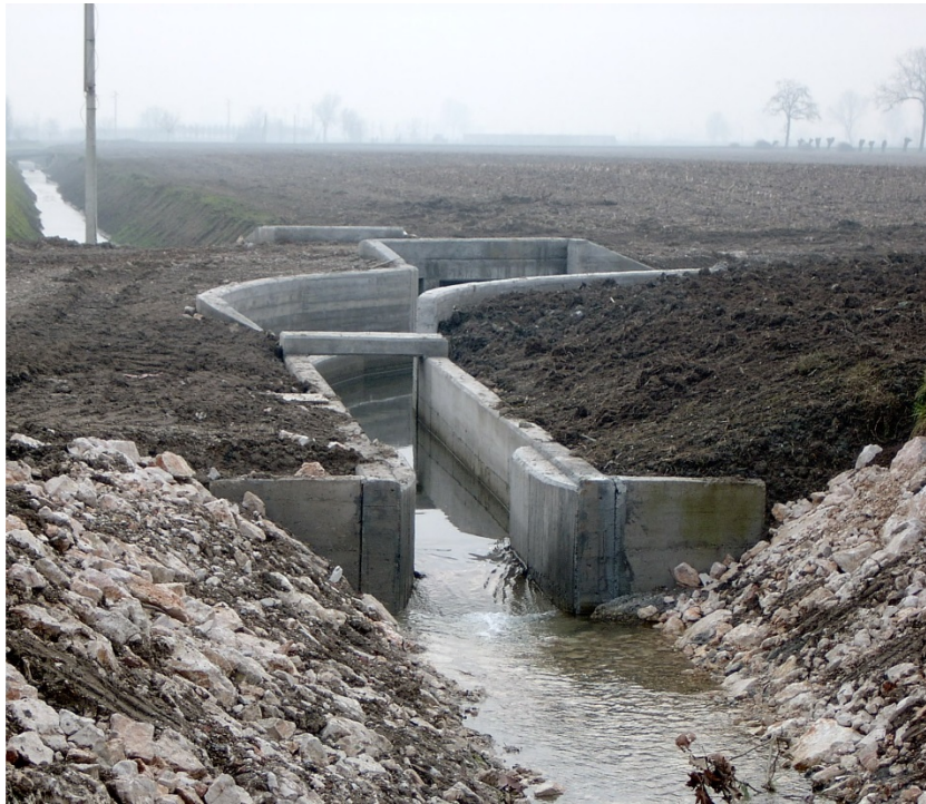
Figura 34 - Manufatto di scarico dal cavo Magio in Scaricatore Piadena (in sx nella foto).
