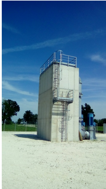
Figura 45 - Pozzetto imbocco Diramatore Pieve San Giacomo.
