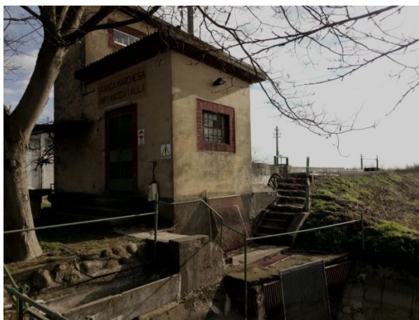
Figura 153 – Impianto irriguo Stanga Marchesa/Vialli.
