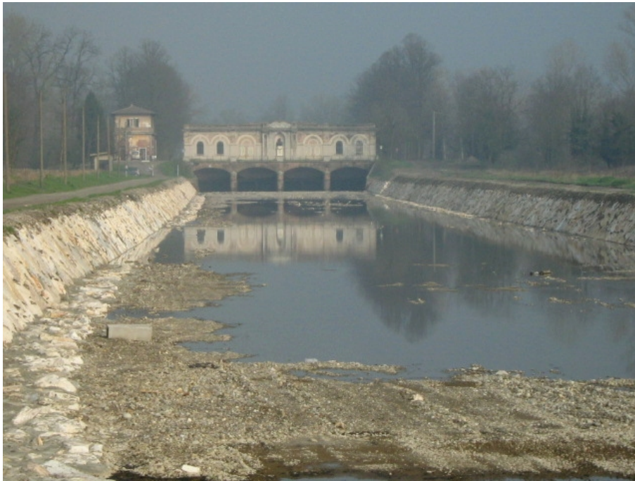
Figura 73 – Opera di presa del Canale Vacchelli dal fiume Adda.
