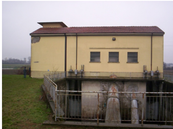
Figura 146 – Impianto idrovoro 'Tencara'.
