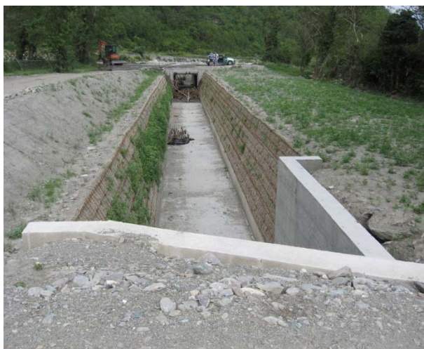
Fig. 2-3: Scatolari prefabbricati in associazione con terre rinforzate o talee
