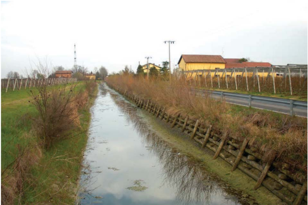
Fig. 4 – Palificata rinverdata nel periodo autunnale, dopo qualche anno dalla fine dei lavori (Fonte: Linee Guida Riqualificazione Canali, Regione Emilia Romagna)
