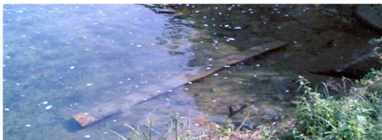
Fig. 9-10 - Introduzione in alveo di detriti legnosi in forma di cumuli (Large Woody Debris) o di semi tronchi necessari per incrementare la diversità morfologica e garantire alla fauna ittica zone di rifugio dai predatori e dalle piene. Foto L. Ruggieri (Fonte: Linee Guida Riqualificazione Canali, Regione Emilia Romagna)
