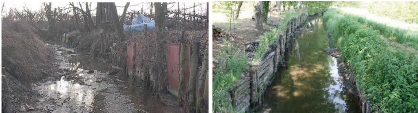
Fig. 7-8 – Palizzata rinverdita: Canale di San Pietro prima dei lavori e dopo 5 anni dalla realizzazione della palificata viva (Fonte: Linee Guida Riqualificazione Canali, Regione Emilia Romagna)
