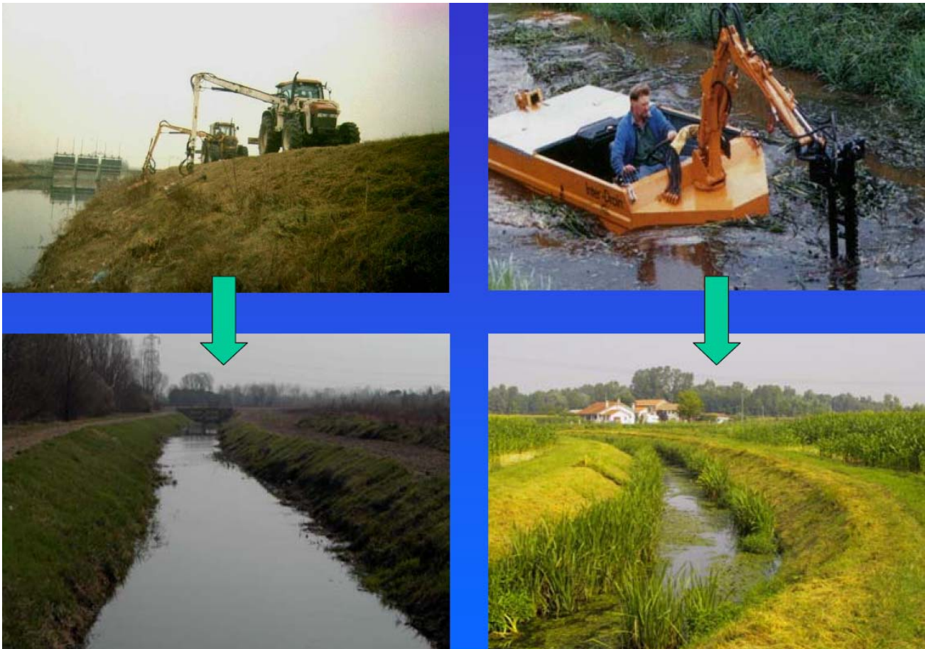
Fig. 1- Sistemi di manutenzione tradizionali e "gentili": a confronto il risultato delle operazioni (da "Il caso dei canali irrigui e di bonifica: tecniche ed esempi applicativi di riqualificazione idraulico-ambientale", ing. M. Bacci, 2005)
