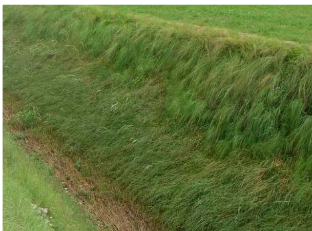
Fig. 2: Interventi di idro-semina
