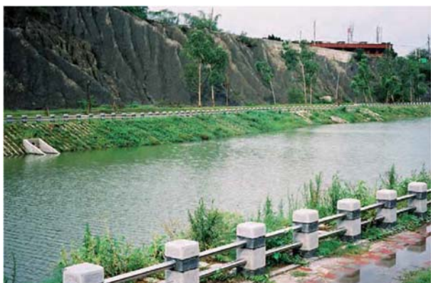
Fig. 2-3: Interventi di idro-semina - applicazione pratica a cura di Huesker spa
