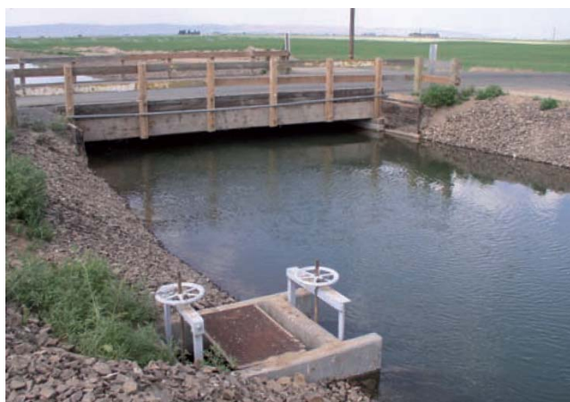
Fig. 3: Rivestimento spondale con inerti – applicazione pratica cura di Huesker spa
