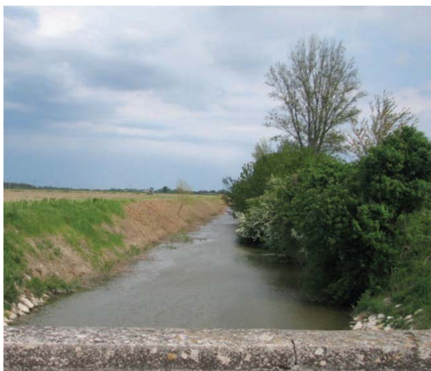
Fig. 2 - Sviluppo naturale di filari arboreo- arbustivi su una sponda di un canale, nel quale la sponda opposta è mantenuta priva di copertura al fine di poter comunque accedere all'alveo - Consorzio della bonifica Burana. (Fonte: Linee Guida Riqualificazione Canali, Regione Emilia Romagna)
