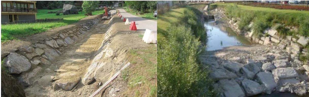
Fig.1-2 Realizzazione soglie in blocchi o massi ( fonte: [www.factor20.it](http://www.factor20.it) – Ream Recupero ambientali)
