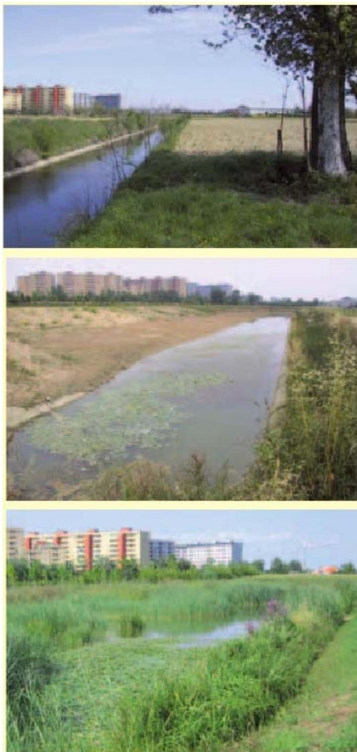
Fig. 1 - Allargamenti di sezione Collettore Favaro per creazione aree allagabili con vegetazione palustre -consorzio bonifica- Acque Risorgive (Fonte: Linee Guida Riqualificazione Canali, Regione Emilia Romagna)
