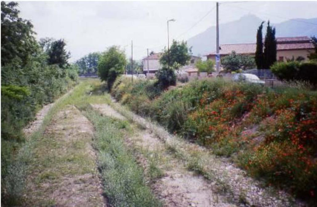
*Fig. 8 - Realizzazione di savanella di magra nel caso di portata scarsa e intermittente per concentrare le acque per il mantenimento degli habitat igrofilii . Acque concentrate in un alveo di magra. Rio Inferno Cassino (FR). Foto P. Cornelini*
