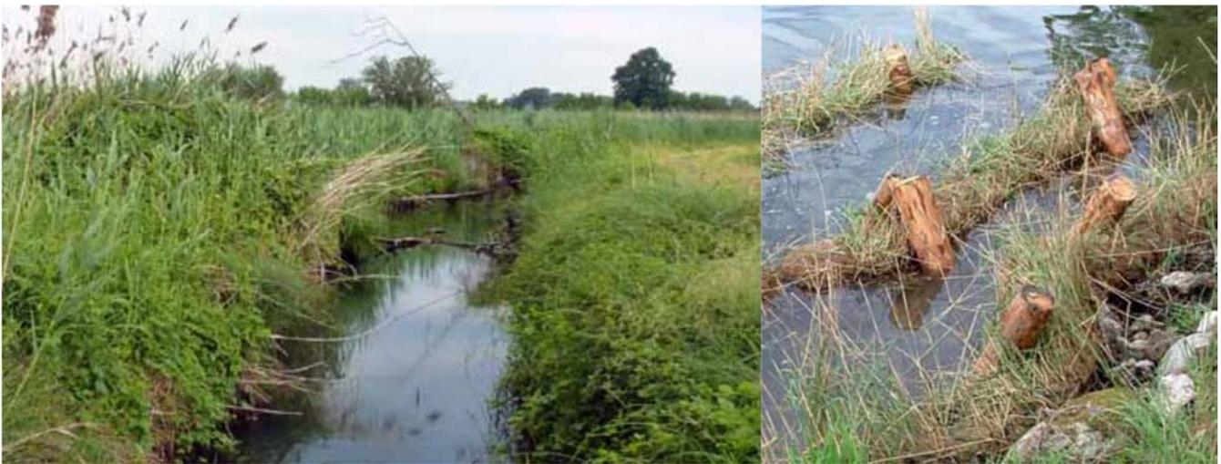
Fig.3-4 Formazione di canneti/cariceti e posa di rulli di elofite ( fonte: Manuale gestione naturalistica Parco del Ticino)
