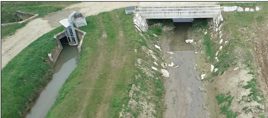
**FIGURA 8-7 FOTO INQUADRATA DA SUD ESTRATTA DAL RILIEVO CON IL DRONE DOVE SONO VISIBILI LE STRUTTURE DA OTTIMIZZARE PER IL MIGLIORAMENTO DELLA CIRCOLAZIONE DELLE ACQUE**
