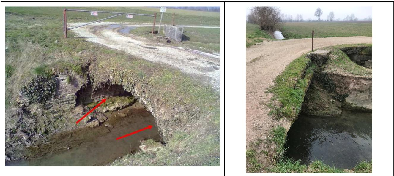
**FIGURA 8-3 PONTE ESISTENTE DA DEMOLIRE E RICOSTRUIRE: A SINISTRA VISTA DA MONTE, A DESTRA VISTA DA VALLE**
